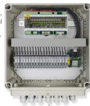
Verbindung zum Geräte- oder Batterieschrank via kurzschlussfestem Kabel
